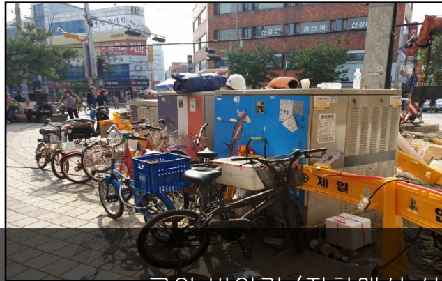
*고압 변압기 (지하매설 식 기기 함, 22,900V, 500KAV) 2019년08월 포항 죽도시장 변압기4대, 개폐기1대 설치
