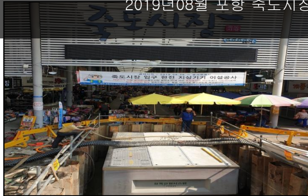
*고압 변압기 (지하매설 식 기기 함, 22,900V, 500KAV) 2019년08월 포항 죽도시장 변압기4대, 개폐기1대 설치
