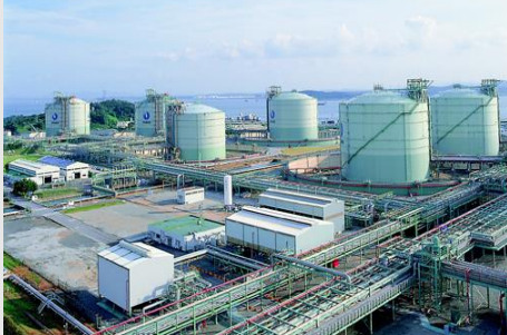
[Pyeongtaek LNG TML]
